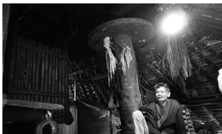
⑫伝統的な構造を維持するスンバ島の家。主柱に鼠返しがあるのは西部集落の特徴
